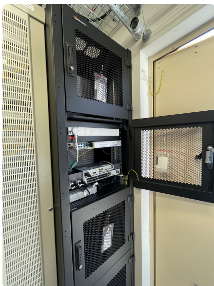
Baie - porte collecte GFU à Castelsarrasin
