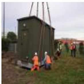
8. Installation des locaux techniques
