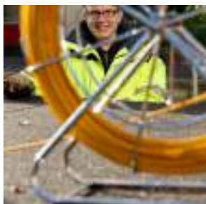
7. Tirage de câbles
